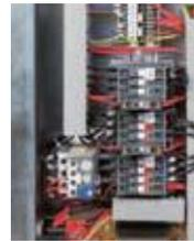
Cuadro eléctrico IP54, integrando arranque temporizado estrella / triángulo.
