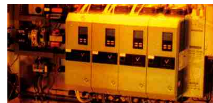
Equipo apilable (reduce espacios de instalación)
